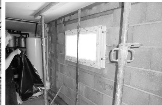
Pose de la fenêtre
